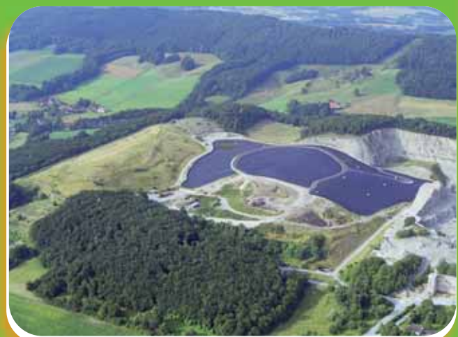
Die geschlossene Deponie in Halle-Künsebeck. Unter der blauen Folie liegen die Restabfälle
