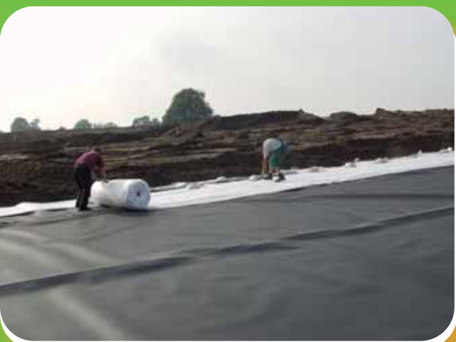
In Rietberg-Westerwiehe wird über die Abfälle eine Folie gelegt. Darauf kommt ein Vlies und anschließend der Boden
