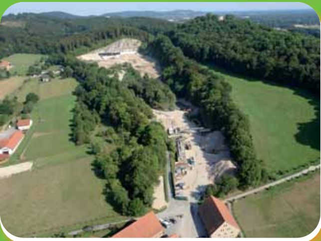
Auf der Deponie in Borgholzhausen dürfen nur Boden- und Bauschuttabfälle gelagert werden
