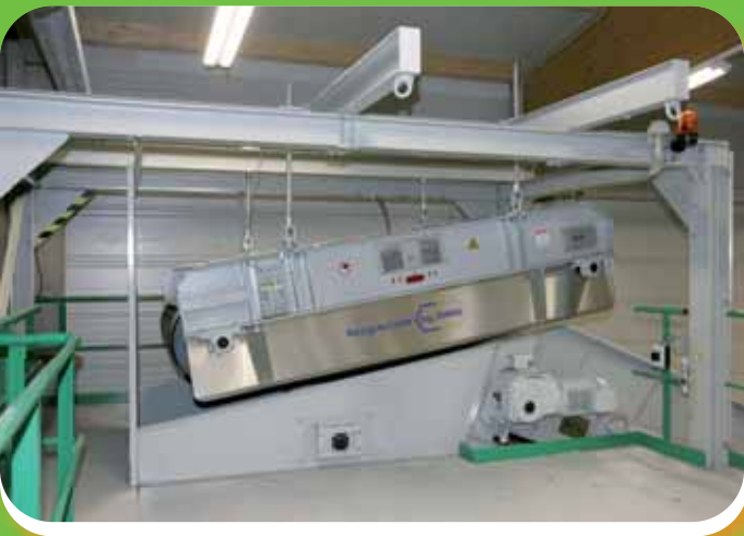
Ein großer Magnet, wir sagen Magnetabscheider, zieht die Metalle aus den Abfällen
