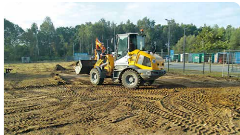
Entsorgungspunkt Gütersloh: Neben an der Erweiterung gebaut.
