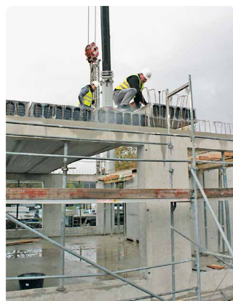
Im September wurde die Decke gegossen. Die neue Wertstoffwerkstatt nimmt langsam Form an.
