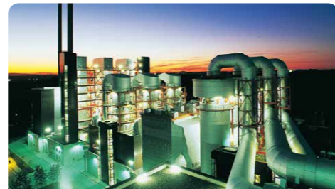
Müllverbrennung ist eine sinnvolle Ergänzung zur mechanischen Abfallbehandlung.
