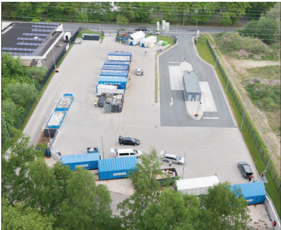
Abbildung 14: Luftbild des Entsorgungspunktes Gütersloh in der Stadt Gütersloh
