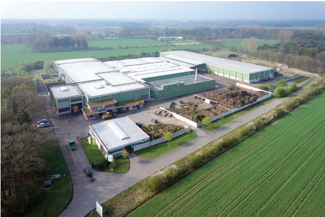
Abbildung 13: Luftbild des Kompostwerkes KOMPOTEC in der Stadt Gütersloh
